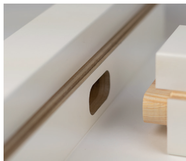
Kämpfer-Pfosten-Verbindung
